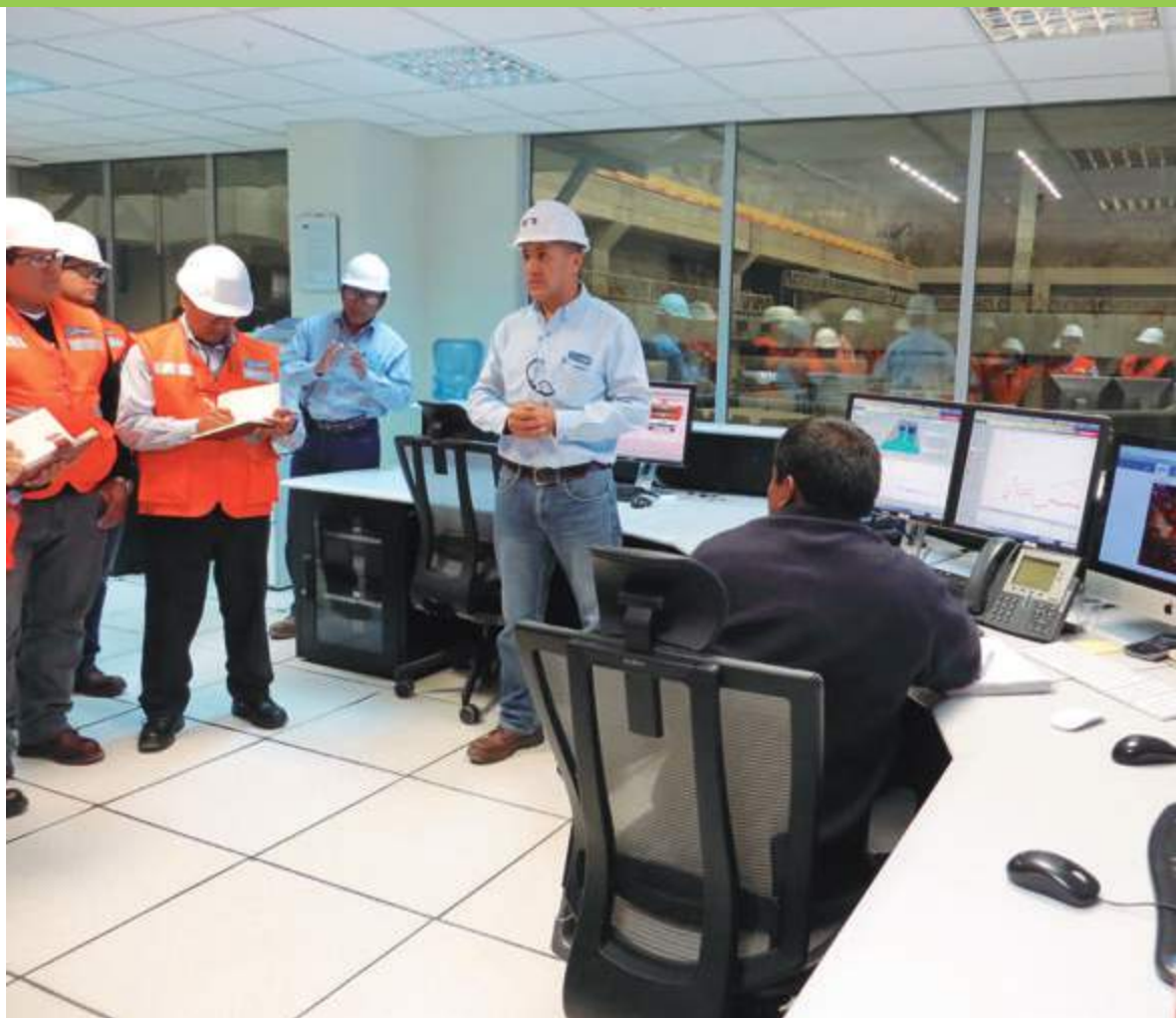
® Compañía Eléctrica El Platanal
