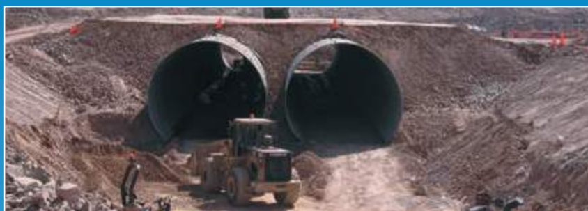
Túnel de Alcantarillas de Acero.
